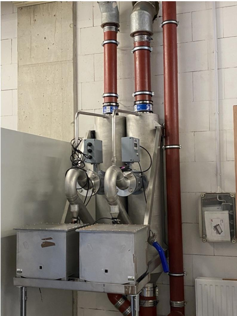
Bild 10: Eingebaute Abflussmessvorrichtung [Quelle: LHH, eigenes Foto]
