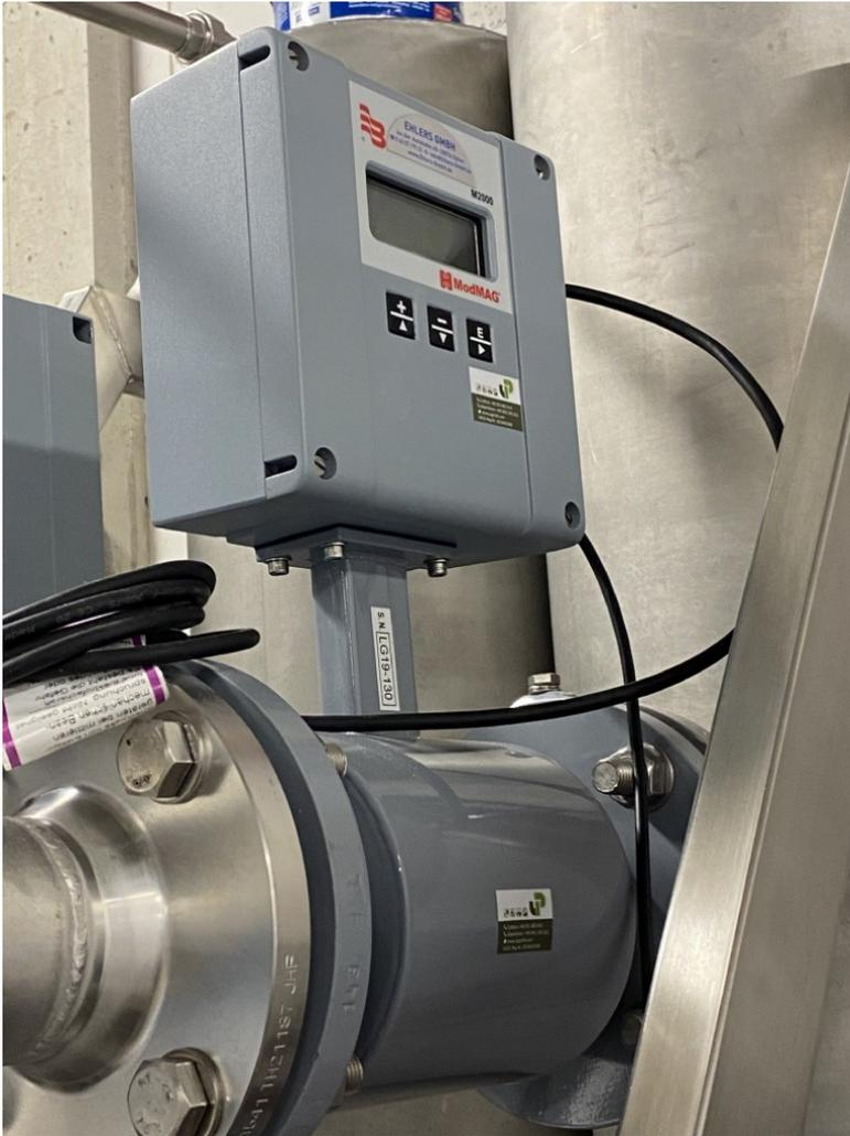
Bild 11: MID der Abflussmessvorrichtung [Quelle: LHH, eigenes Foto]
