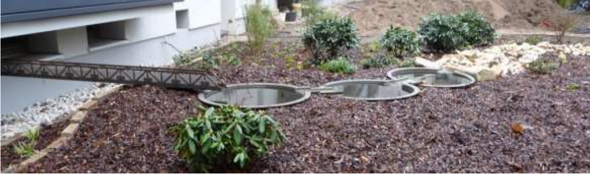
Bild 1-10: Zisternen-Kaskaden-System im umgestalteten Innenhof der Wohnungsgenossenschaft Gartenheim, Bildquelle: ISAH
