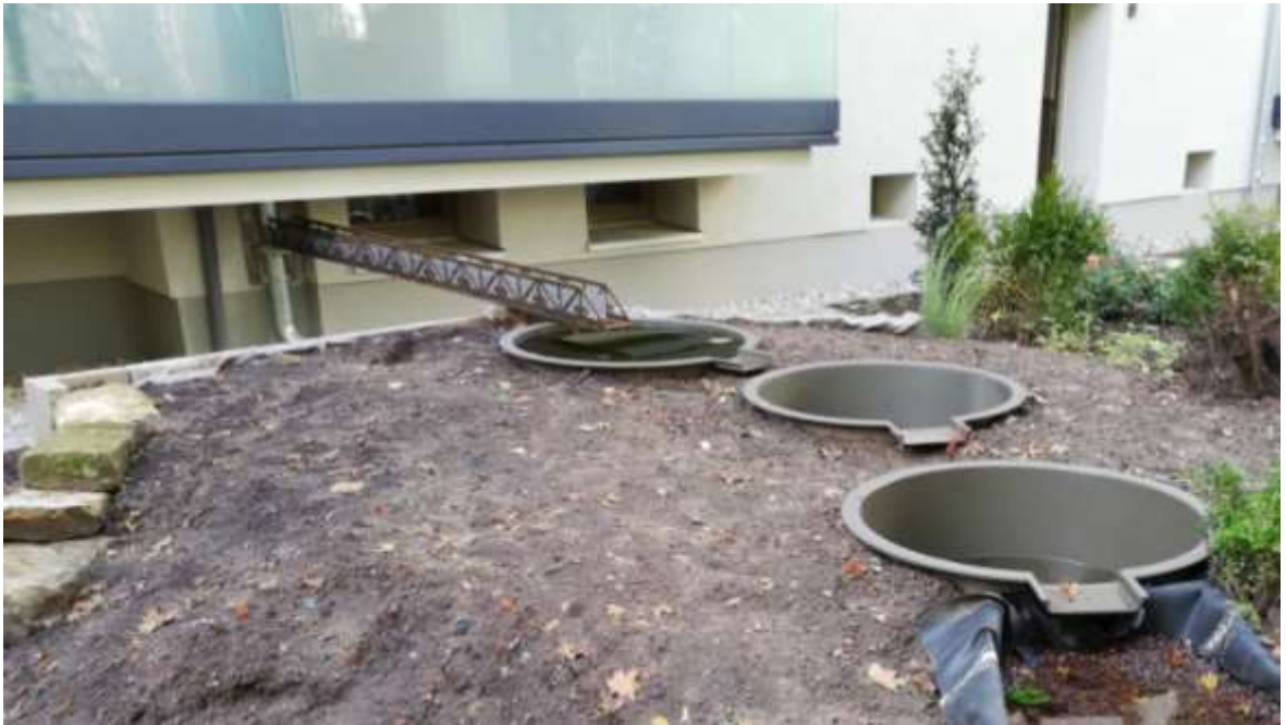
Bild 1-4: Zuleitung Niederschlagswasser von Dach im Westen zum Teich im Innenhof. Bildquellen: ISAH
