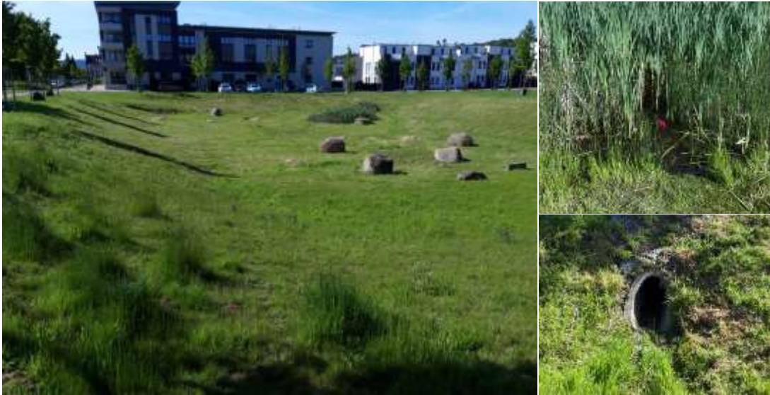
Abbildung 3-3: Regenrückhaltebecken Steinberg; links: Übersicht; rechts oben: Feuchtareal mit Spuren von spielenden Kindern; rechts unten: Ablaufleitung
