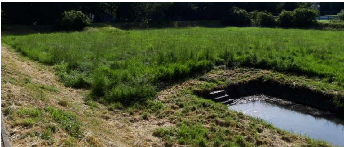
Abbildung 3-1: Regenrückhaltebecken Philosophenweg vor der Umzäunung
